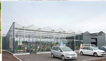
Die Anlieferung ist beim Neubau getrennt.
